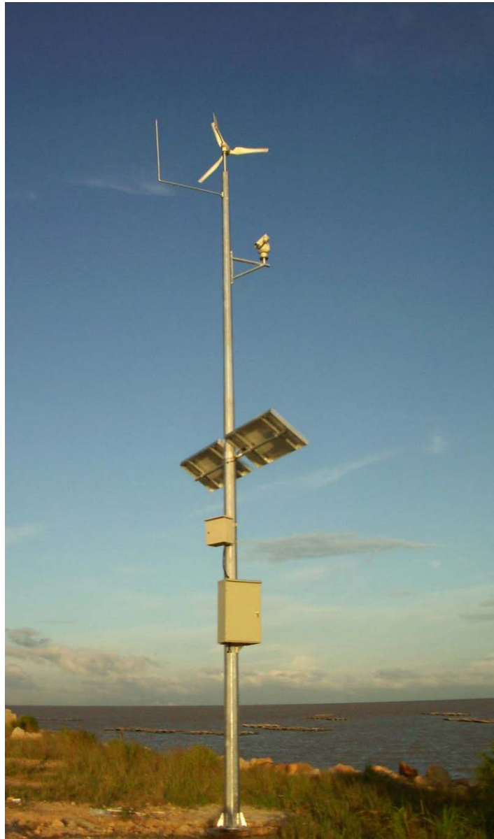
图：风光互补供电系统河道监控应用
